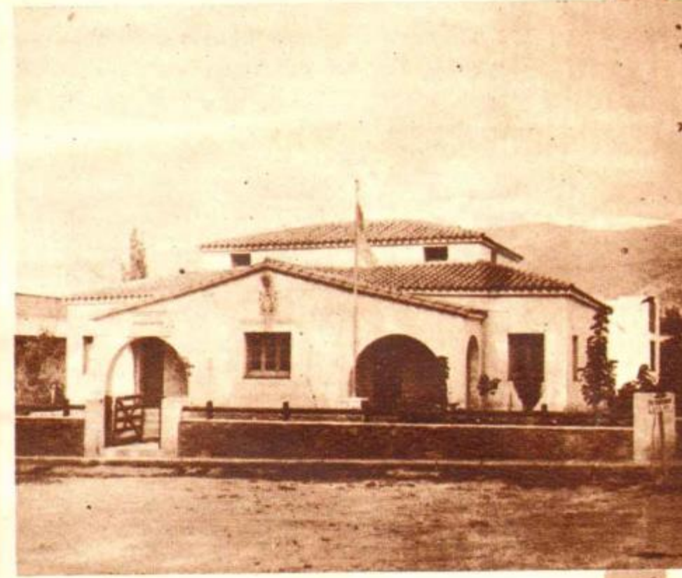
Entre las nuevas oficinas públicas del Tipo A, construídas en Catamarca, se encuentra la de La Merced, que costó pesos 61.397,20.
