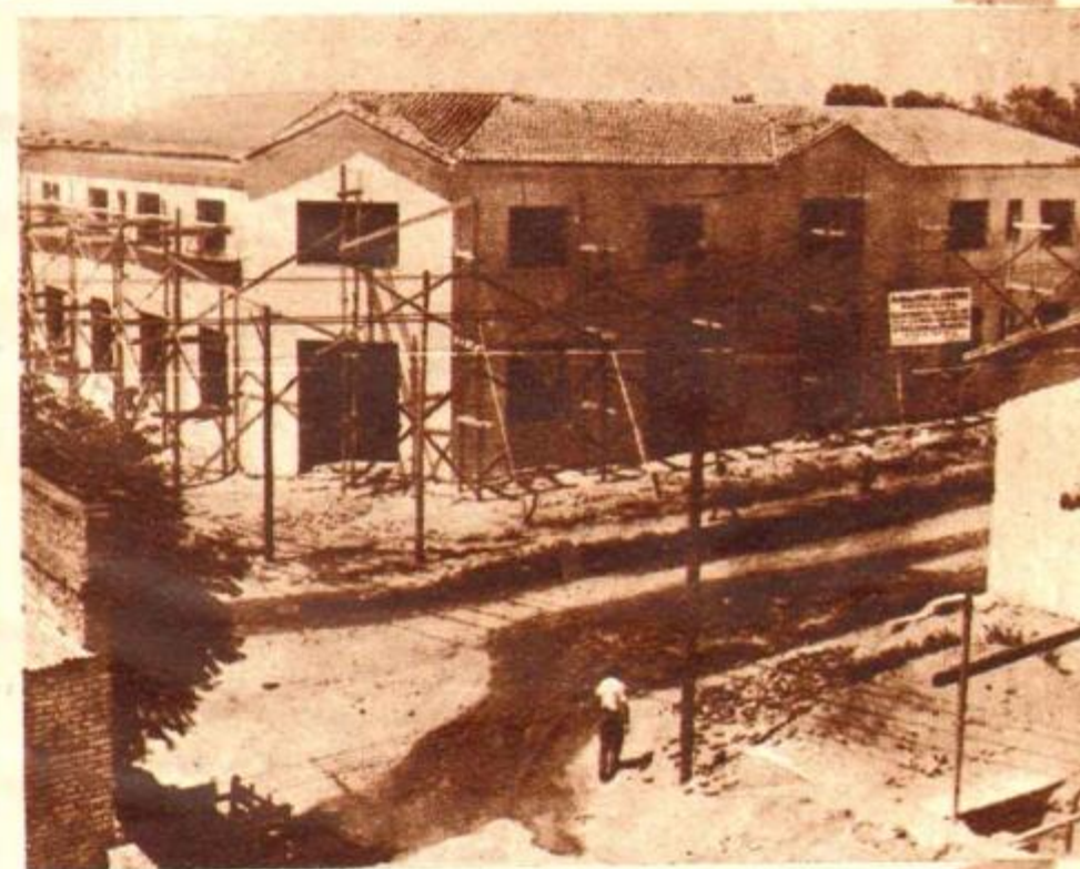
En la construcción del edificio de la Dirección de Rentas, en la ciudad de Catamarca, fueron invertidos $ 478.646,85.
