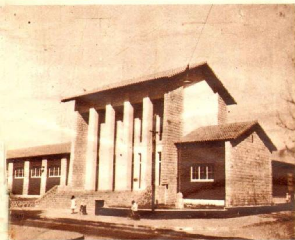
Para la ampliación y el perfeccionamiento de las industrias regionales fué construída esta moderna Fábrica de Cerámica en Catamarca.
