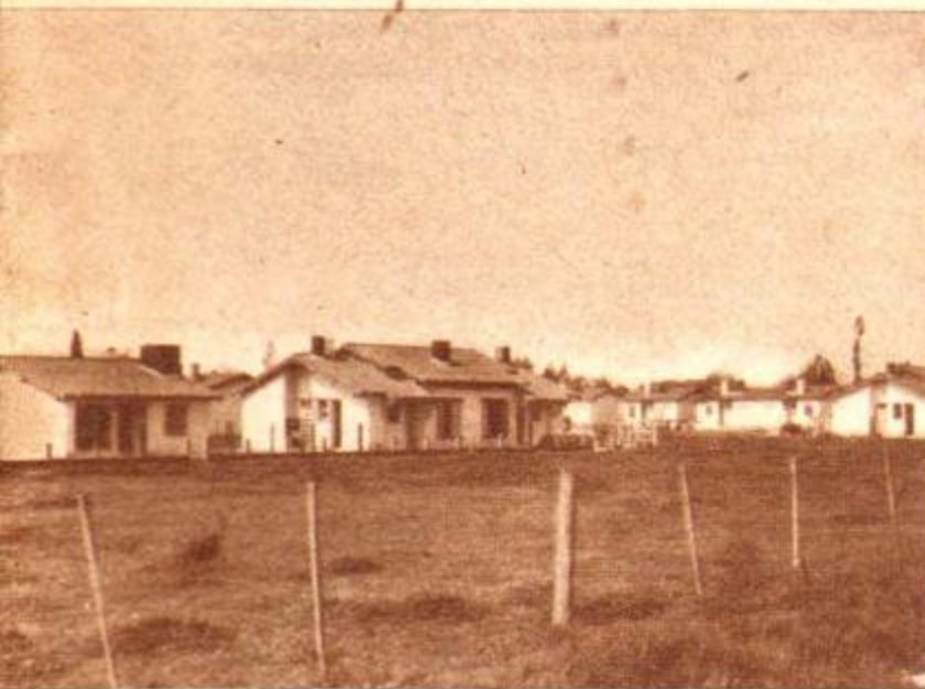
También en la localidad de San Andrés de Giles el Gobierno Justicialista ha construido un moderno y confortable barrio obrero.
