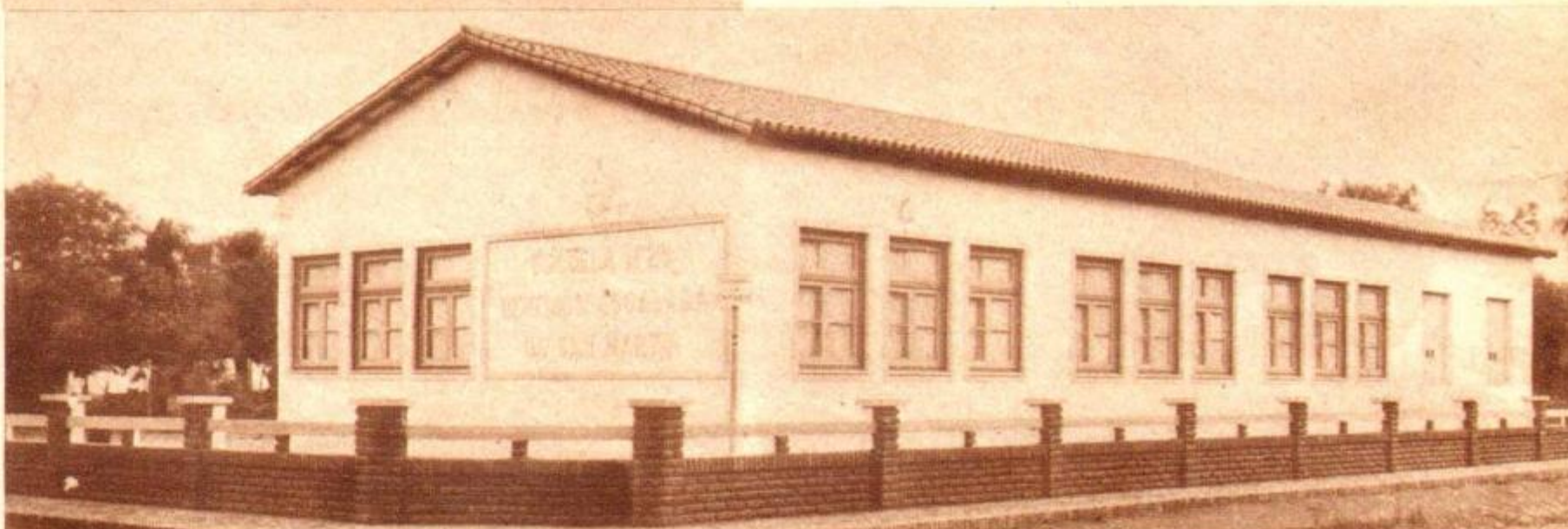
En la estación Pinzón, distrito de Pergamino, fué construída esta moderna escuela, que lleva el nombre de la esposa del Libertador.
